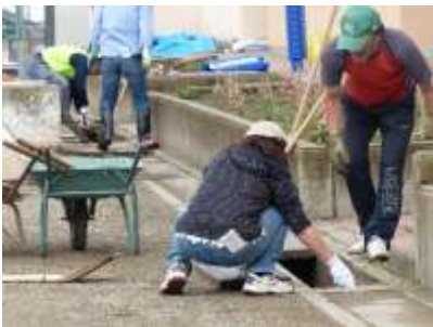
【グラウンド側溝掃除】
